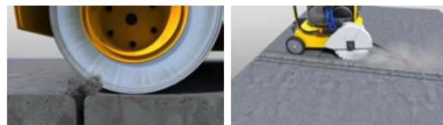
Instalação de Junta Signature AR finalizada que permite o movimento direcional do tráfico
