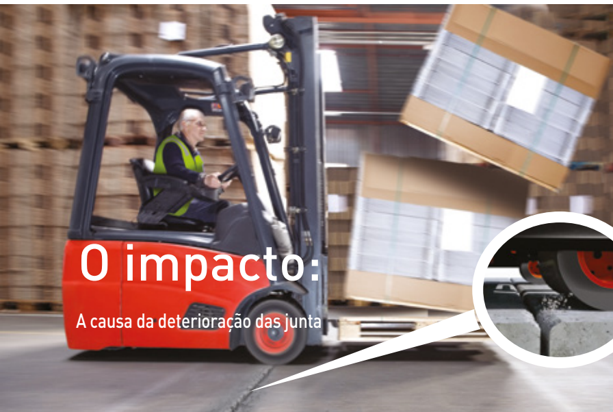
Junta danificada que apresenta uma deterioração pelo impacto
